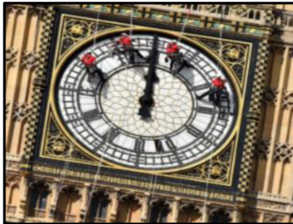
Fig.2 Personas trabajando en el Big Ben [Reubicación de píxeles de figura original].
