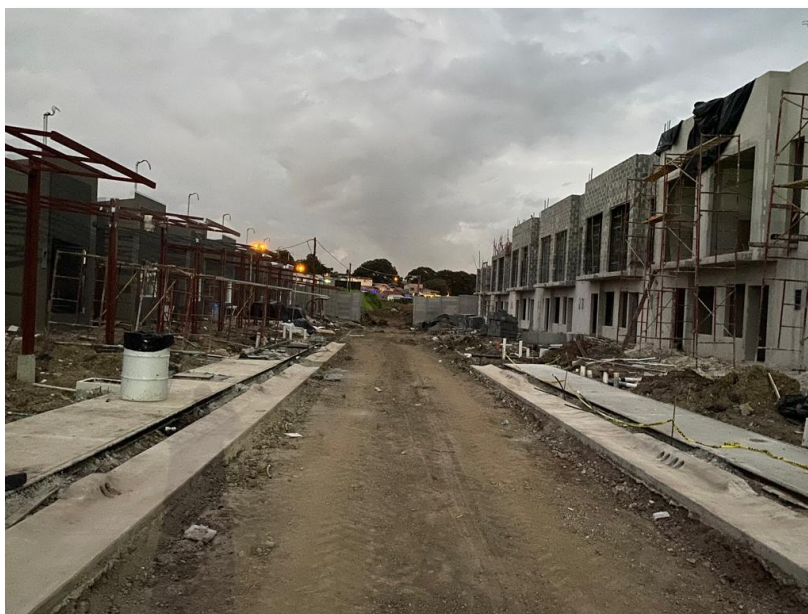
Figura 13. Proceso constructivo de casas en condominio Akari, Ciruelas Alajuela.
