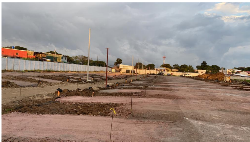
Figura 12. Trabajos de urbanismo en propiedad de condominio Akari en Ciruelas de Alajuela.
