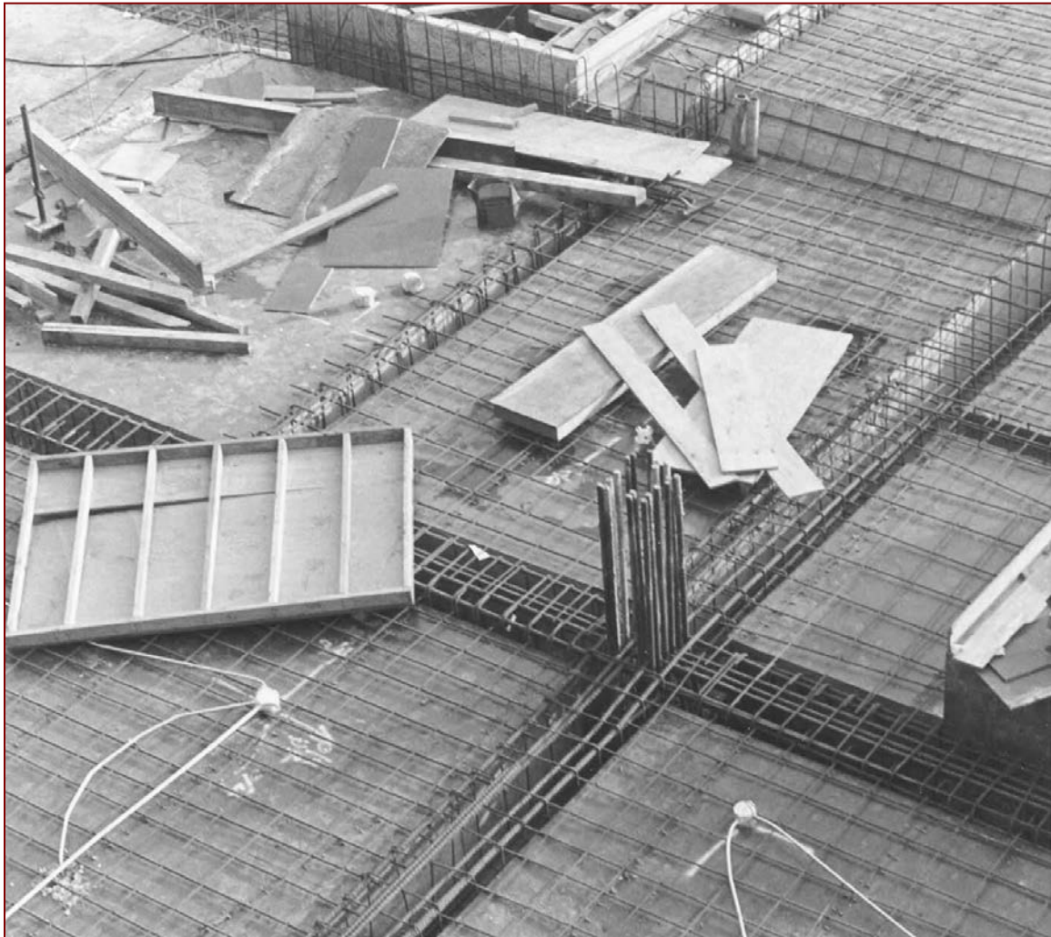
Figura 4–25 Intersección de columna con vigas. (Fotografía cortesía de J.G. MacGregor.)
