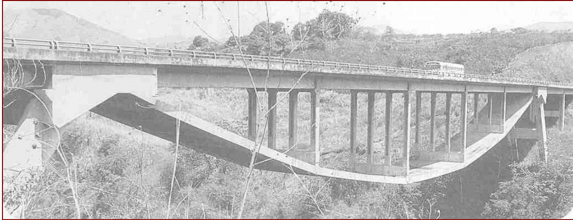
Figura 1-3 Puesto postensado de suspensión, con un claro central de 124 metros, sobre el Río Colorado, Ruta Nacional 1, Costa Rica (Diseño T.Y. Lin Internacional-Indeca Ltda.; supervisión MOPT-BEL Ingeniería; construcción Carrez Int. S.A.).
