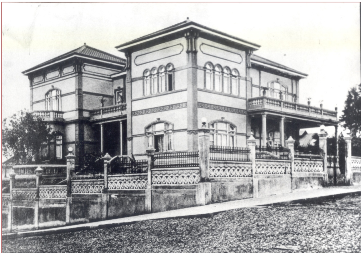
Primer edificio con muros de concreto reforzado construido en Costa Rica (1908). Castillo Azul del Lic. Máximo Fernández Alvarado, hoy día propiedad de la Asamblea Legislativa, San José, Costa Rica
