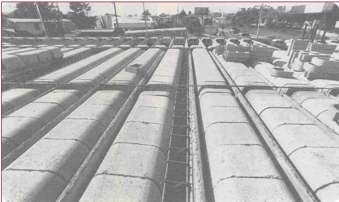
Figura 1-4 Detalle de la instalación de un entrepiso de viguetas pretensadas en las vigas coladas en sitio (Cortesía de Holcim-Costa Rica).
