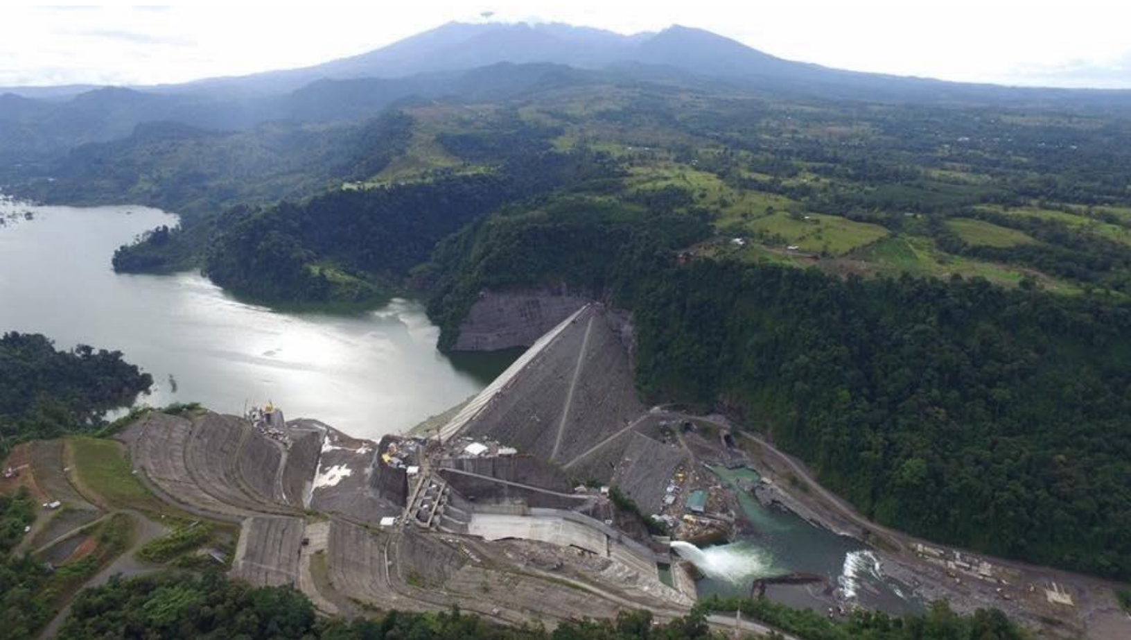
Imagen 54: Vista aérea de la Represa Hidroeléctrica del Río Reventazón.
