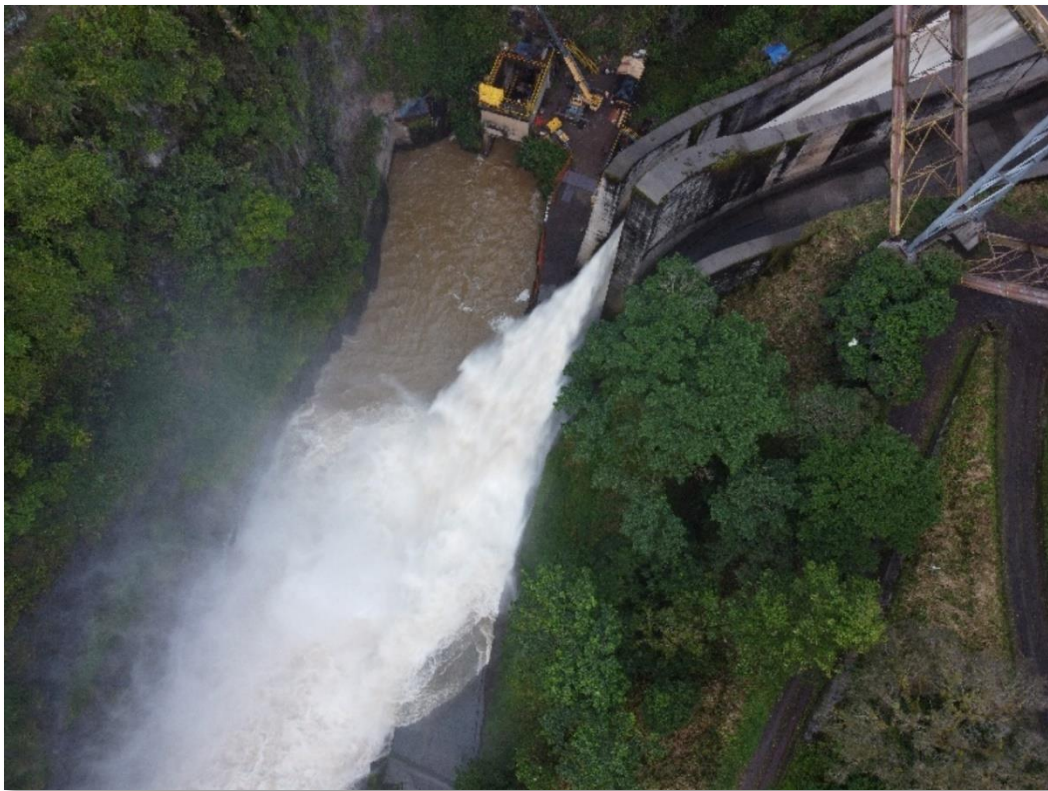
Imagen 53: Vista aérea de la Represa Hidroeléctrica Cachí, Paraíso, Cartago.
