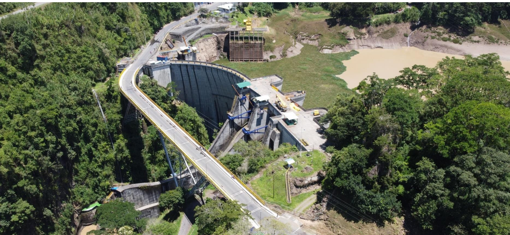
Imagen 56: Vista aérea de la Represa Hidroeléctrica Cachí, obra de infraestructura emblemática y elemento característico del paisaje de Paraíso de Cartago.
