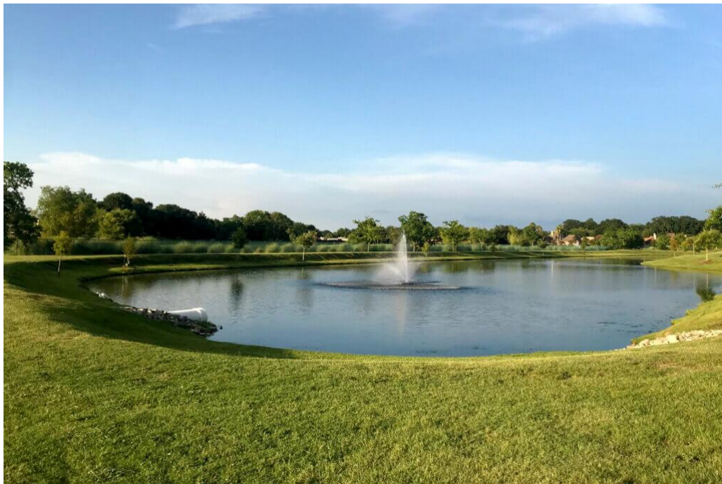
Imagen 77: Cuencas de retención y detención
