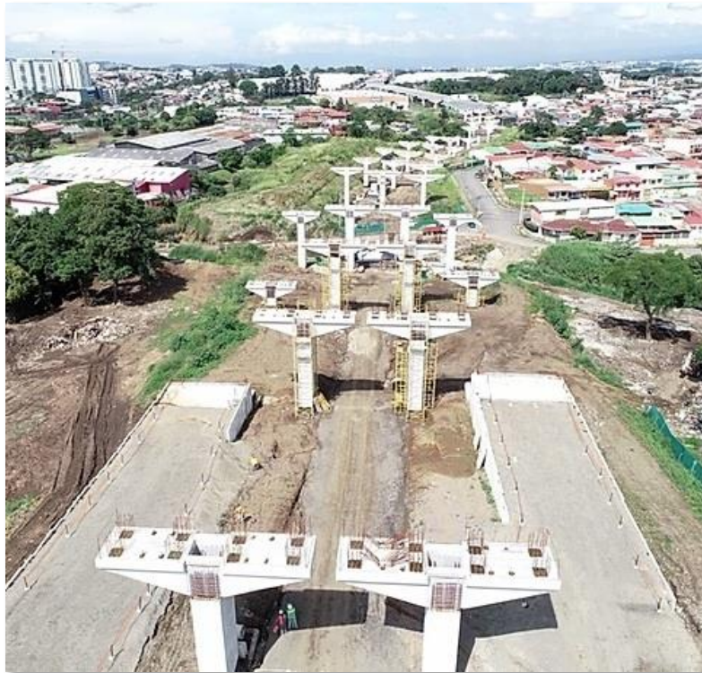
Imagen 69: Construcción de la Circunvalación Norte, proyecto que a nivel visual y paisajístico tiene aciertos y desaciertos y que afecta directamente el paisaje urbano, pero a su vez, brinda una visión del paisaje urbano nunca vista en San José.
