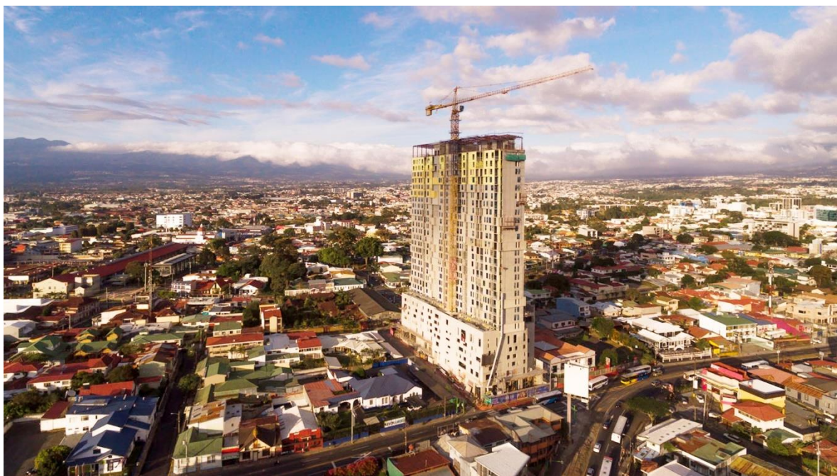
Imagen 88: Edificio Urbn Escalante, bloqueando la vista que existía hacia el Volcán Irazú, muestra de la poca protección del paisaje en la Ciudad de San José.
