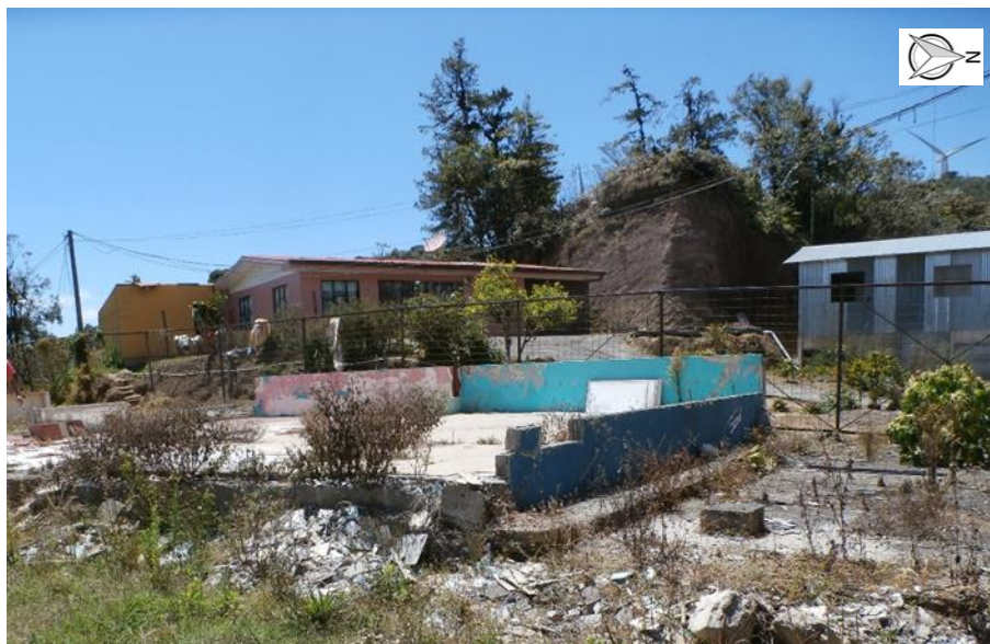
Figura 48. Vista de los escombros en el lote escolar. Fuente: Fotografía propia, 2019.
