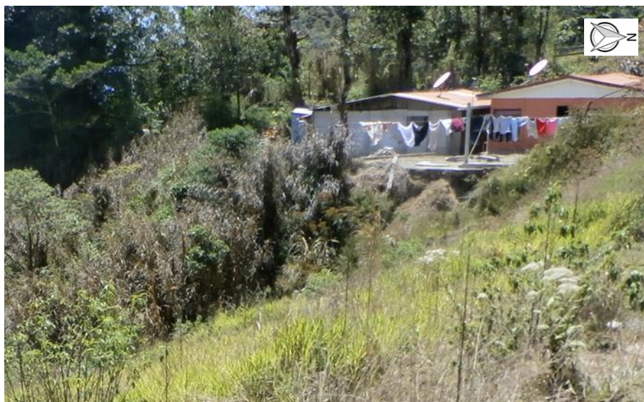
Figura 52. Viviendas habitadas a pocos metros del deslizamiento. Fuente: Fotografía propia, 2020.
