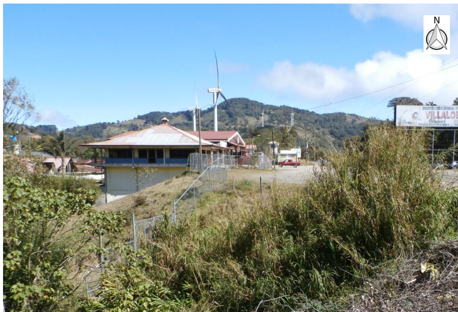
Figura 29. Perspectiva del terreno 2. Fuente: Fotografía propia, 2019.
