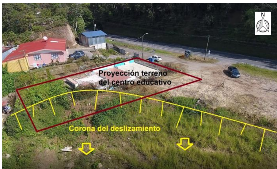
Figura 46. Pérdida de infraestructura escolar sobre la ruptura del terreno. Fuente: Elaboración propia, 2020.
