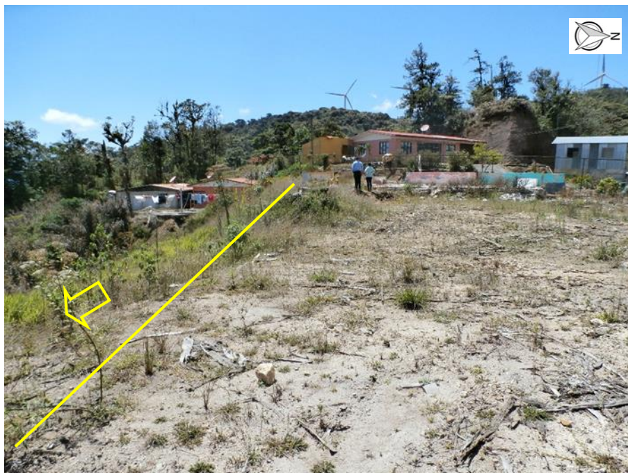
Figura 44. Corona del deslizamiento a nivel del terreno. Fuente: Fotografía propia, 2019.
