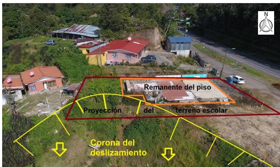
Figura 47. Vista de los remanentes del edificio escolar. Fuente: Elaboración propia, 2020.
