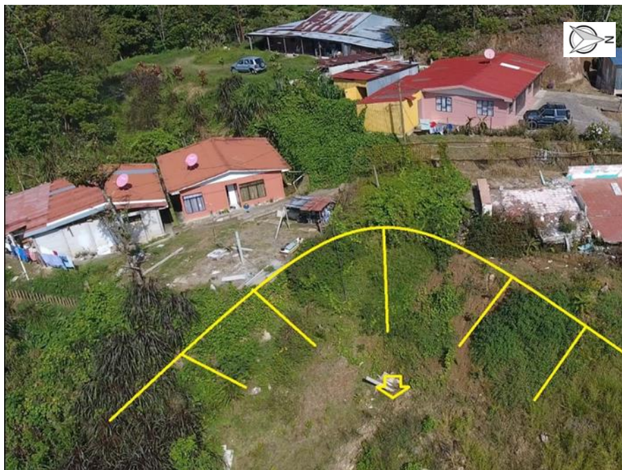
Figura 51. La corona del deslizamiento alcanzó a las propiedades vecinas. Fuente: Fotografía propia, 2019.
