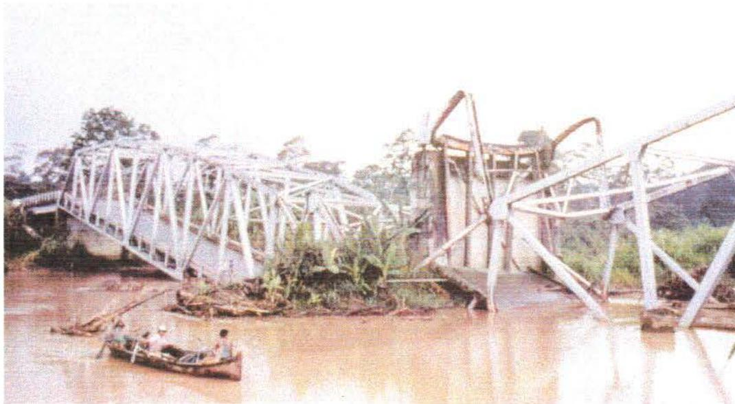
**Fig. E-8: Colapso del puente sobre el Río La Estrella**
