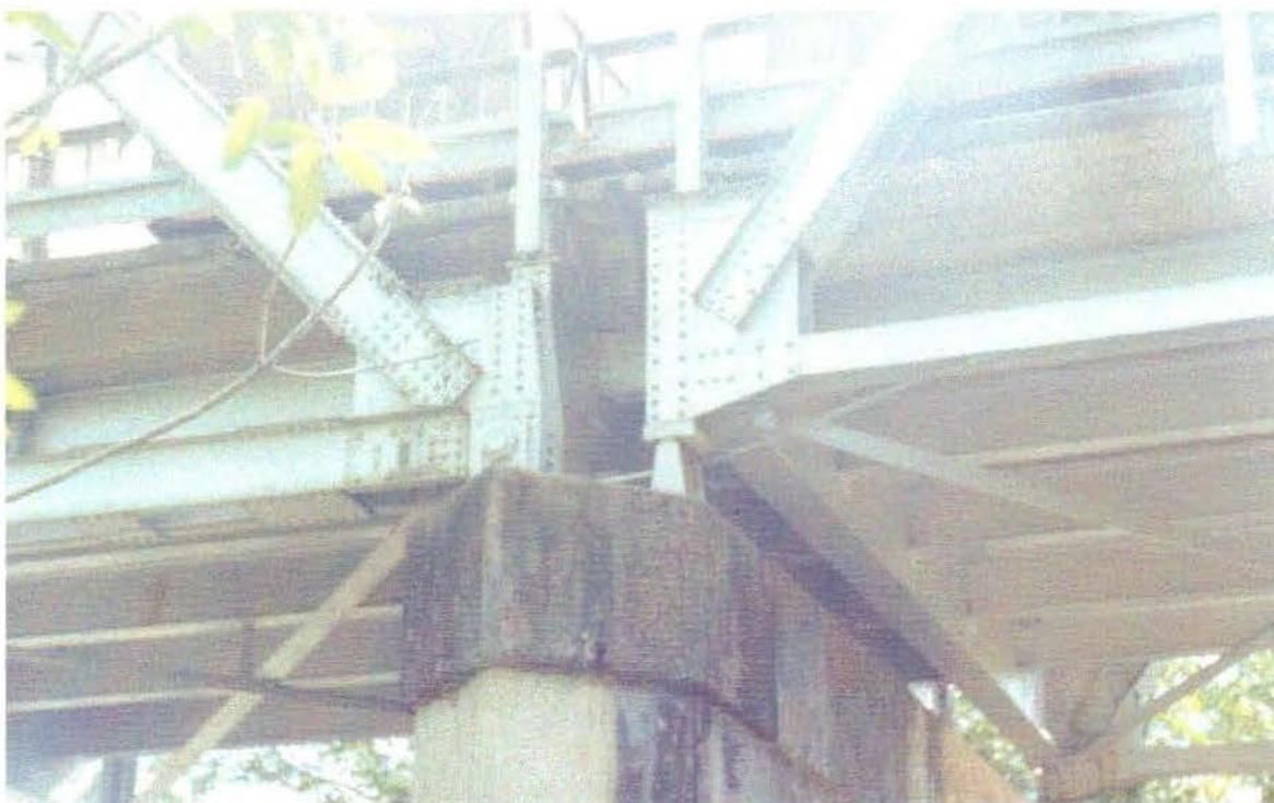
**Fig. F-20: Detalle de unión de las cerchas del puente sobre el Río Abangares**
