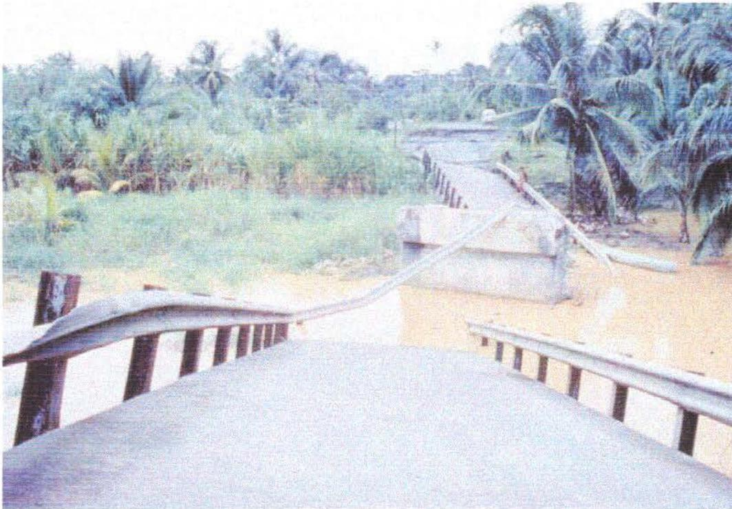
**Fig. E-6: Colapso del puente sobre el Río Bananito**
