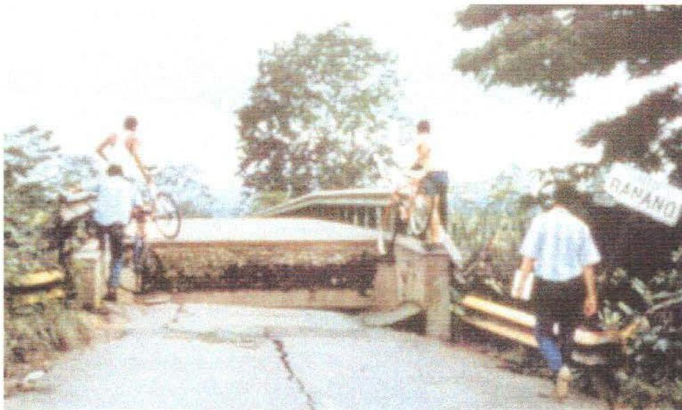
**Fig. E-4: Asentamiento del acceso al puente sobre el Río Banano**
