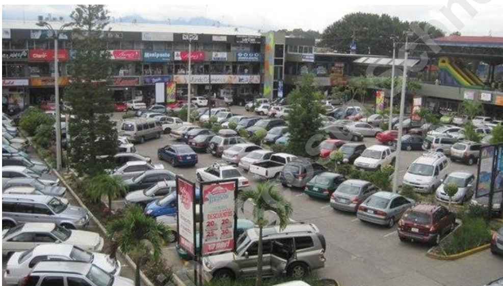
Figura 135. Parqueo del Centro Comercial del Sur, San José (inaugurado en 1979). Fuente: Fallas (2014).
