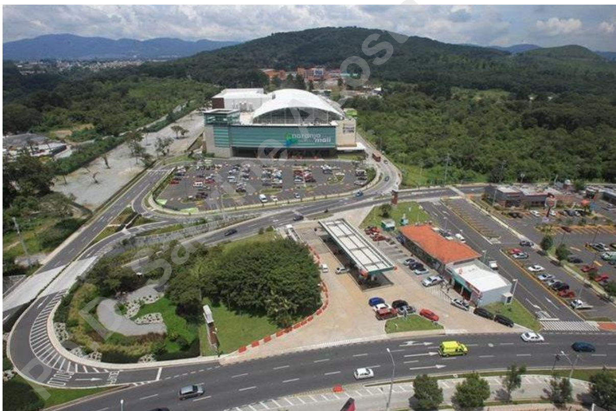
Figura 40. Vista aérea de la sección comercial del proyecto El Naranjo. Fuente: Pitán (2017).
