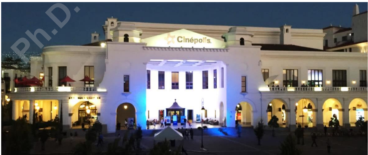
Figura 171. Fachada de los cines frente a la “plaza central” en Ciudad Cayalá. Fuente: acervo de la autora (2018).
