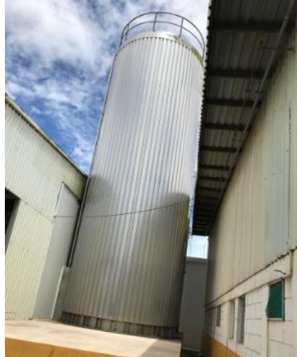
Imagen 2. Silo de almacenamiento de leche.
