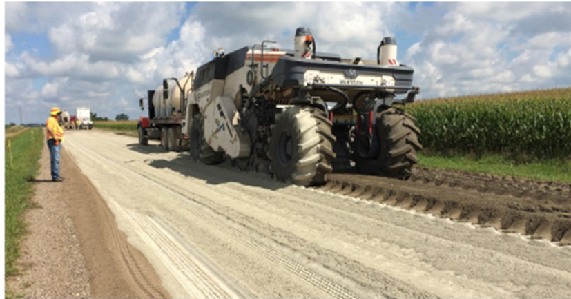
Figura 3. Estabilización de capa de base con cemento (Wegman, Sabouri, Korzilius, & Kuehl, 2017)
