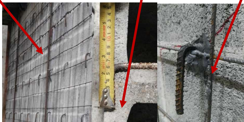
Figura 54. Doblado de pines de varilla No 3.
