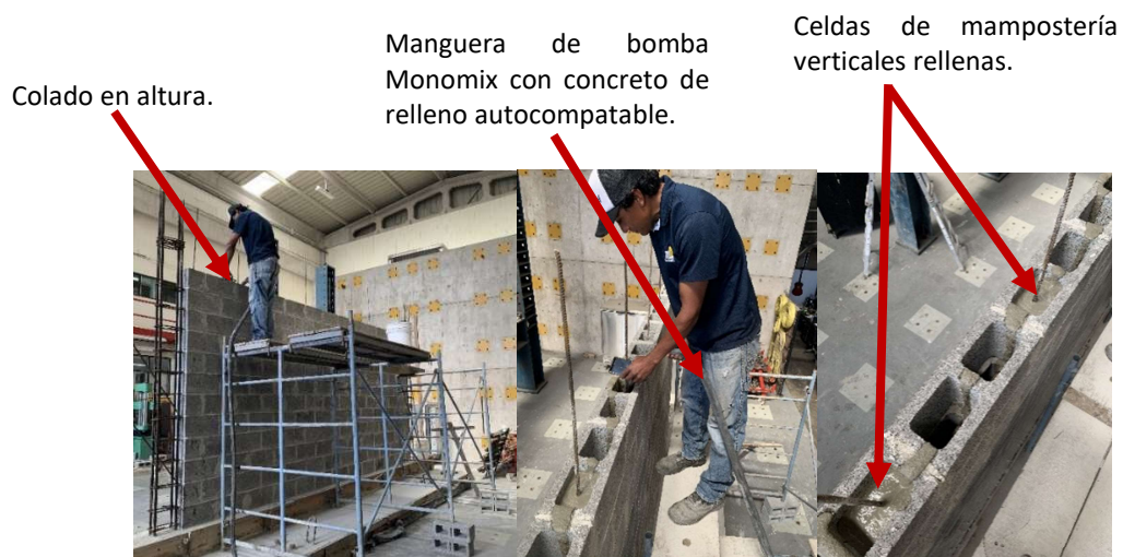
Figura 46. Colado de celdas de relleno.
