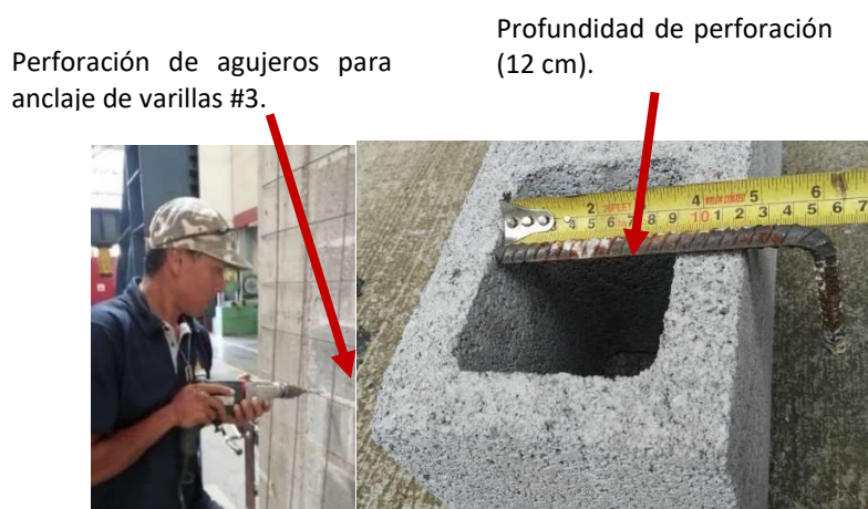
Figura 51. Perforación de agujeros.
