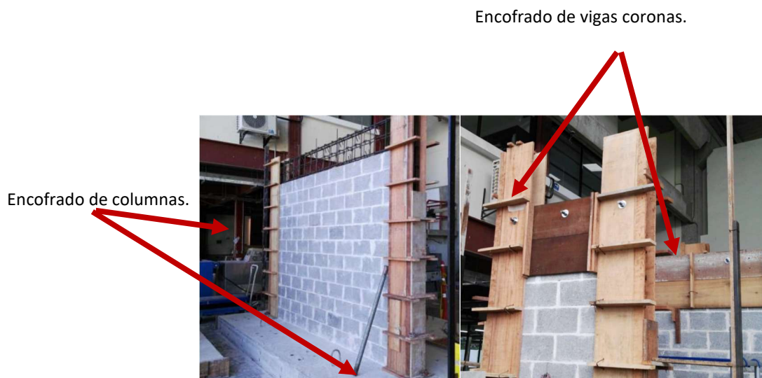
Figura 48. Encofrado de columnas y viga corona.
