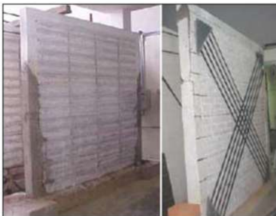
Figura 5. Uso de bandas de acero o plástico en paredes de mampostería (Tomada de Sociedad Mexicana de Ingeniería Estructural, “Rehabilitación sísmica de edificaciones de mampostería para vivienda” , Jorge Ruiz García, Queretaro 2007).
