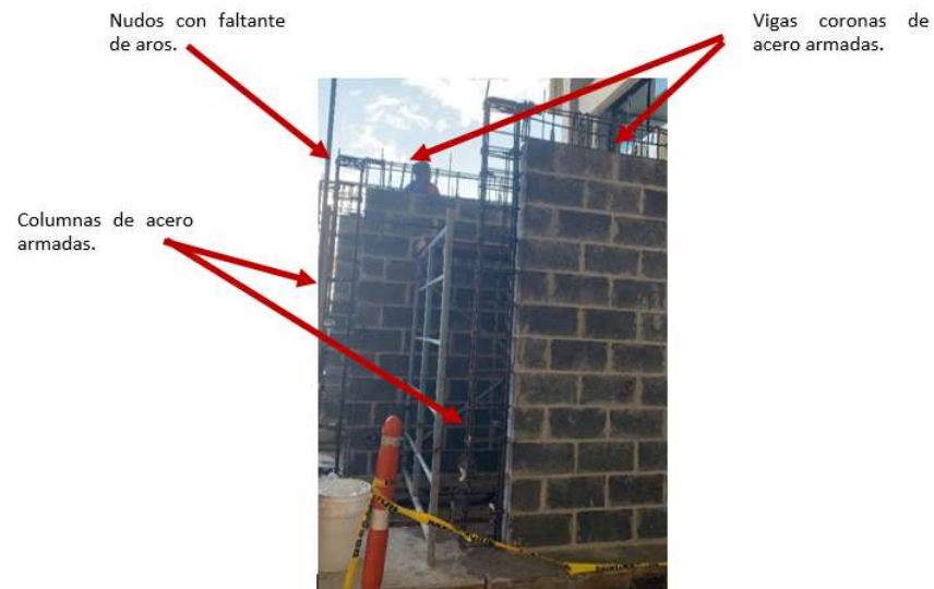
Figura 47. Construcción de columnas y viga corona.
