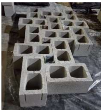
Figura 39. Posición de bloques de mampostería para pruebas de concreto de relleno.
