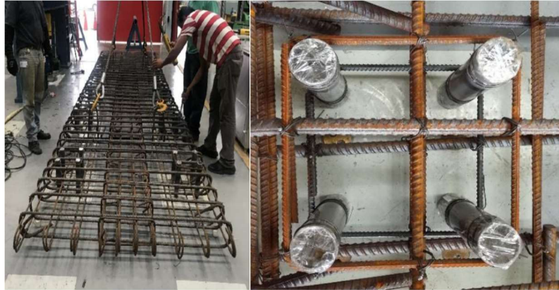
Figura 41. Colocación de ductos en fundaciones.
