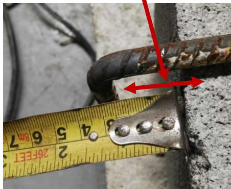
Figura 55. Espesor del recubrimiento con mortero.
