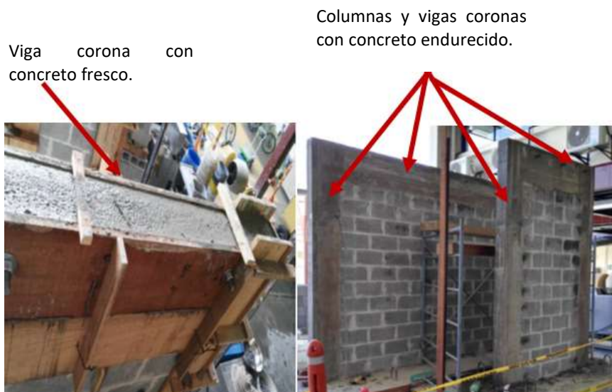
Figura 49. Colado de columnas y viga corona.
