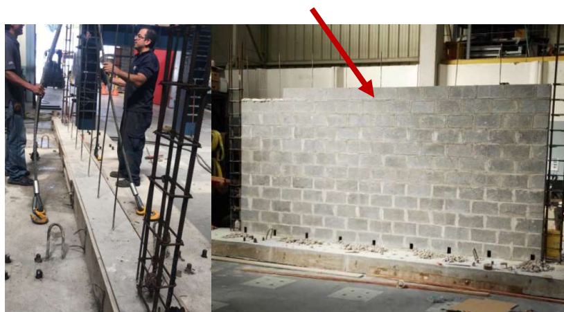
Figura 45. Levantamiento de paño de mampostería.
