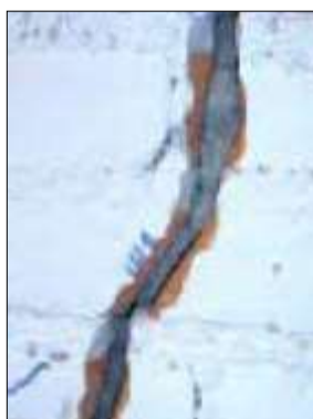
Figura 2. Relleno de grietas en paredes de mampostería (Tomada de Sociedad Mexicana de Ingeniería Estructural, “Rehabilitación sísmica de edificaciones de mampostería para vivienda”, Jorge Ruiz García, Queretaro 2007).
