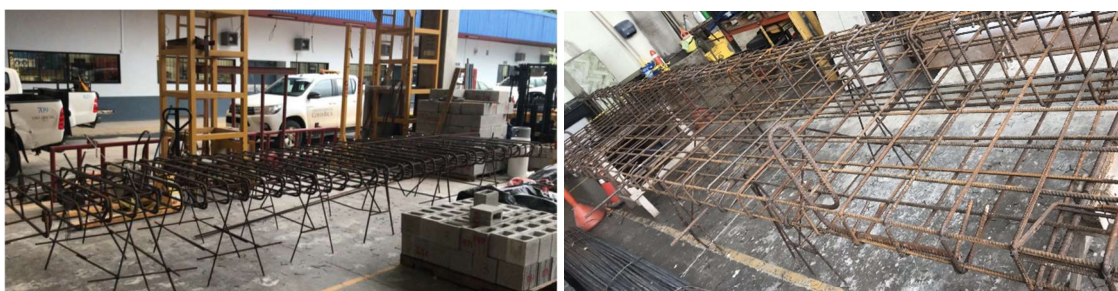
Figura 40. Confección de armadura de fundación en patio del piso fuerte.
