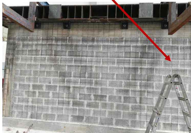
Figura 50. Colocación de malla electrosoldada en la pared.
