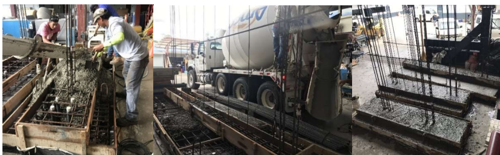
Figura 44. Colado de fundaciones.
