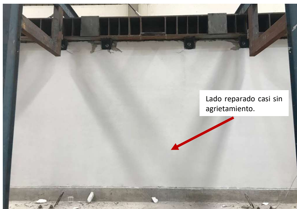
Figura 77. Muro fallado h/l = 0.5 , pared reparada 1.
