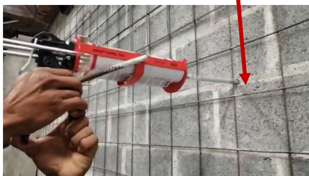
Figura 52. Inyección de gel epóxico.
