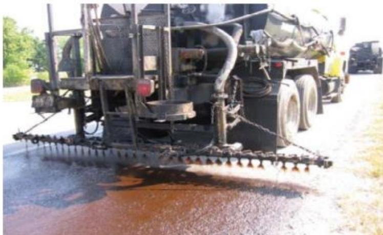
**Figura 20.** Componentes y aplicación de sello de niebla
