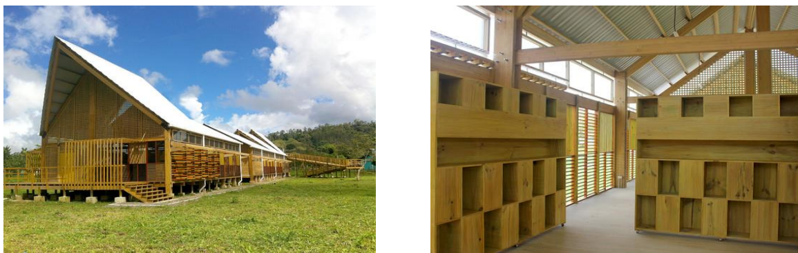
Figura 206. Centro de Capacitación Indígena Kăpäclăjui / Entre Nos Atelier. 2014. situado en la reserva Indígena de Tayutic de Grano de Oro, cantón de Turrialba, en la provincia de Cartago, Costa Rica. (Entre Nos, 2014).
