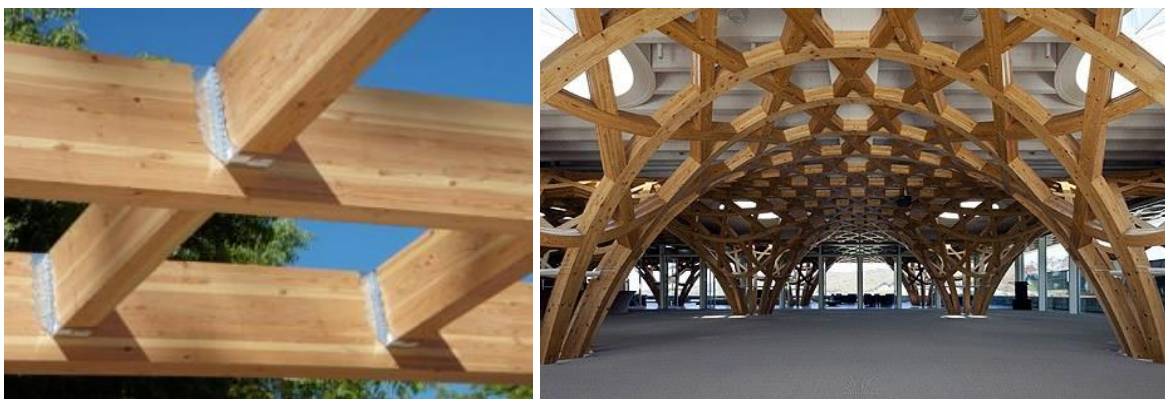
Figura 204. Estructura de entramados en madera laminada. (Timber, 2020).
