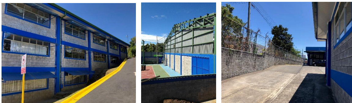
Figura 234. Construcción de estructura metálica y envolventes de mampostería, que brinda a los espacios facilidad para la ventilación e iluminación natural, con elementos de control sobre el asoleamiento directo, facilita el paso del aire a través de ventanas y puertas, y otras aperturas superiores. Fotografías realizadas por el autor (2019).
