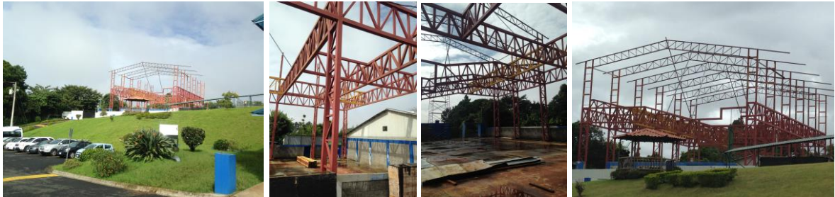
Figura 153. Vistas de la edificación en construcción, según modelo base. Estructura metálica en secciones tubulares de acero. Fotografías por el autor (2018, revisado en 2019).
