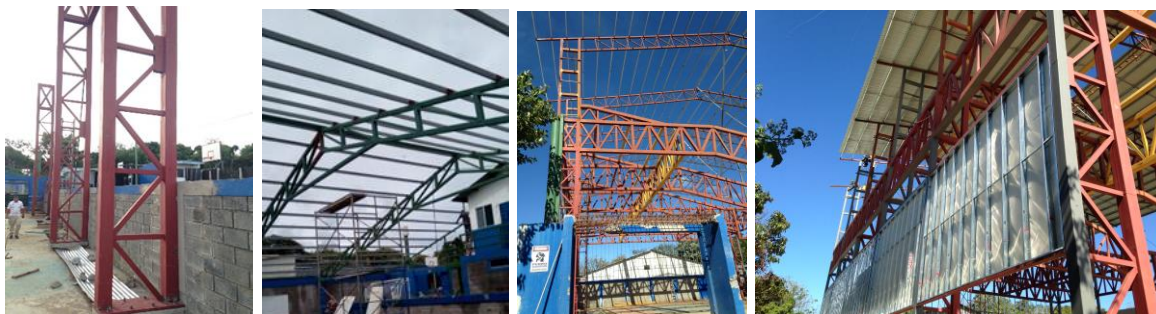
Figura 182. Proceso de construcción en año 2019. Fotografías realizadas por el autor (2019). Se muestra parte de la estructura que cubija al gimnasio y sus columnas, en la segunda Figura se muestra la estructura preexistente que se ha demolido, la cual consistía en marcos de acero para la cubierta del gimnasio.
