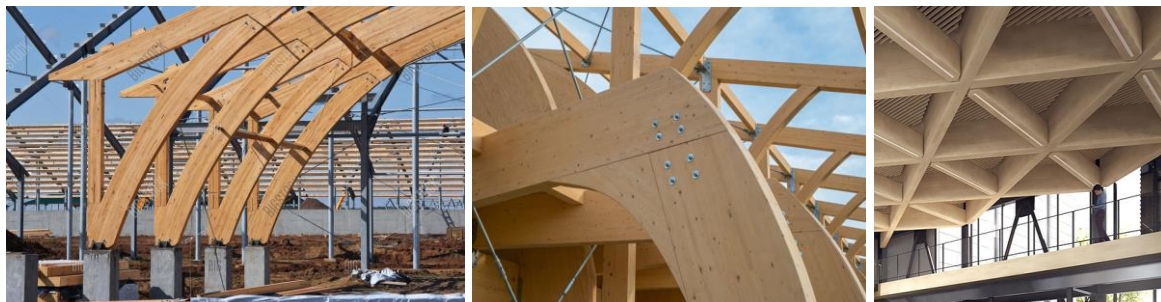
Figura 209. Estructura en madera laminada. (Naturally, 2020).
