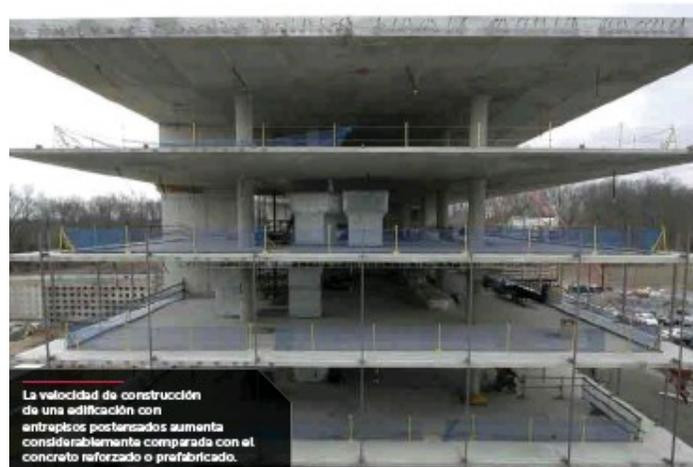
Ilustración 8. Ejemplo de sistema constructivo
