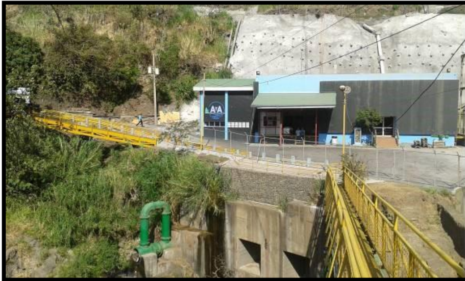
Figura 2-7. Estación de bombeo Puente de Mulas del sistema ME-A-19 Puente de Mulas, Acueducto Metropolitano
