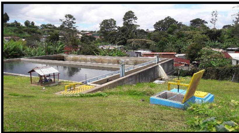
Figura 2-3. Desarenador Los Sitios del sistema ME-A-04 Los Sitios, Acueducto Metropolitano
