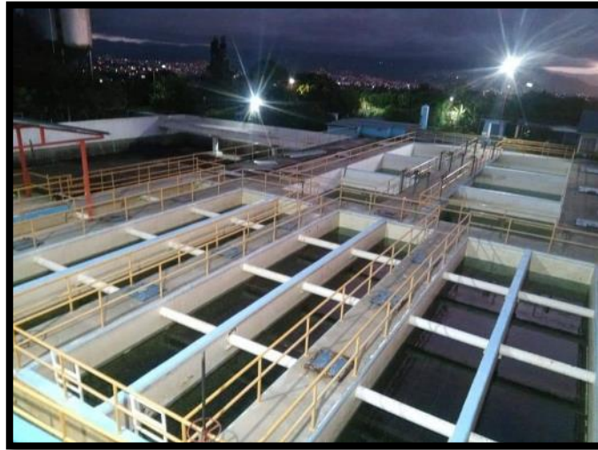
Figura 2-4. Planta Potabilizadora Los Sitios del sistema ME-A-04 Los Sitios, Acueducto Metropolitano
