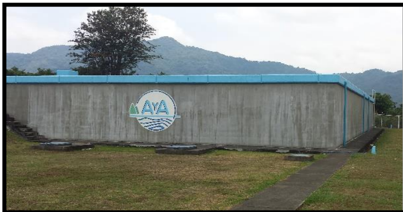
Figura 2-10. Tanque Montufar del sistema ME-A-01 Tres Ríos, Acueducto Metropolitano
