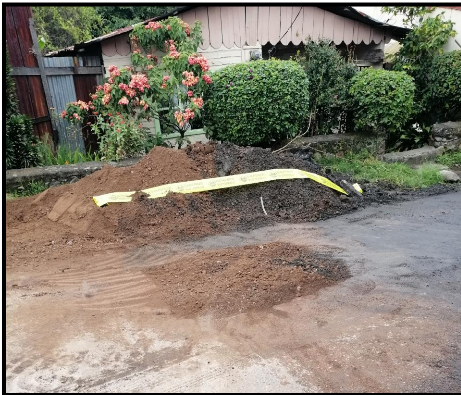
Figura 4-35. Desperdicio de material de relleno sobrante
