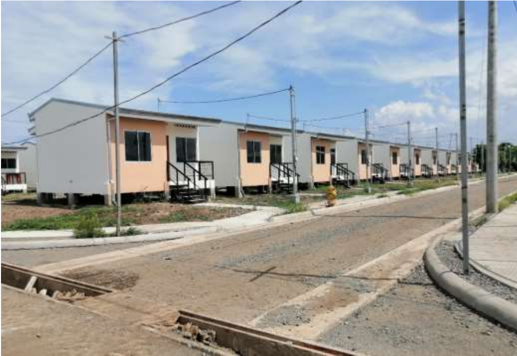
Figura 70. Vistas de avance de obras en Proyecto Santa Fe, abril 2020
