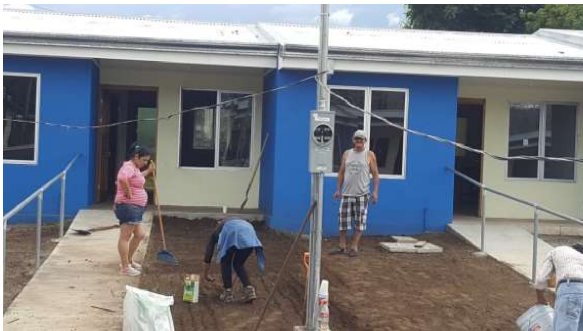
Figura 13. Proyecto vivienda interés social “Real del Dante”, Santo Domingo, Heredia. FUPROVI
