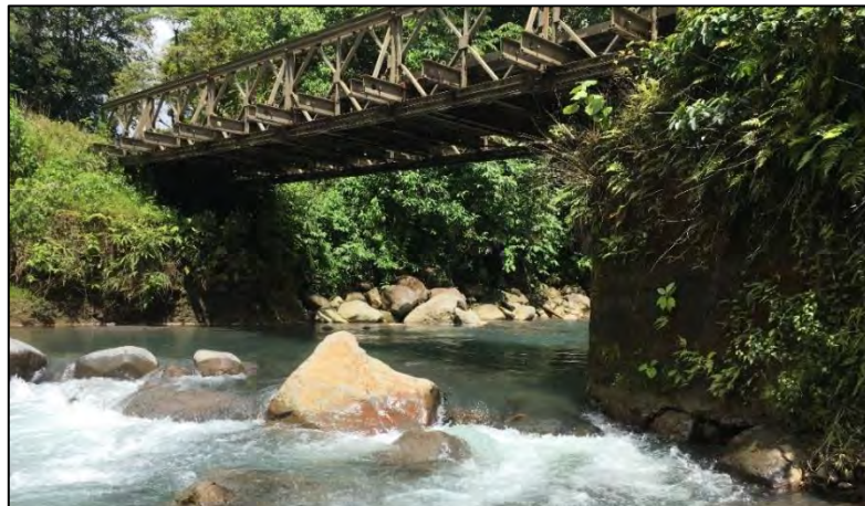
Figura 33: Puente Bailey instalado sobre el cauce del río Azul.
