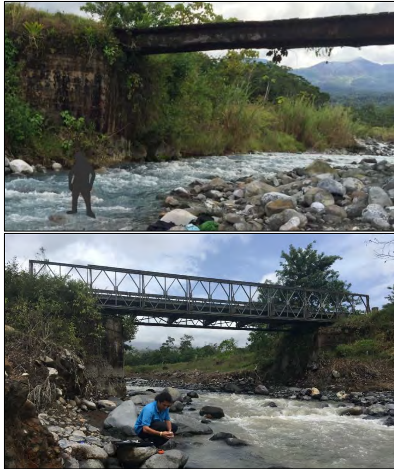
Figura 32: Puente sobre el río Pénjamo. Arriba: Puente de troncos existente hasta 2016; abajo: Puente Bailey instalado para reemplazar el anterior.
