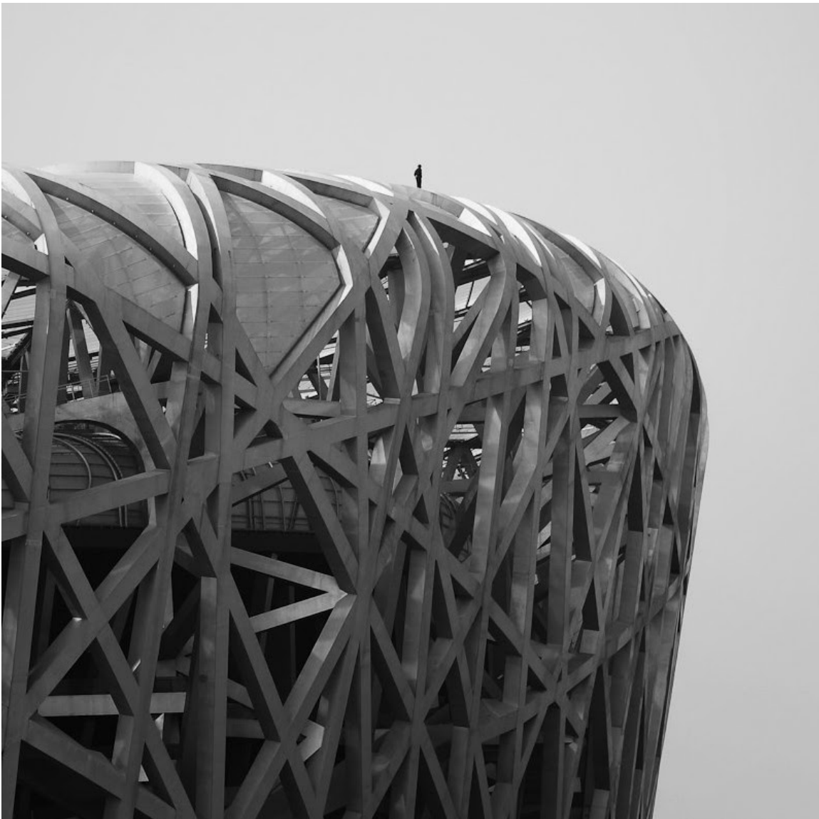
Fig. 18 Sección y vista parcial a través del estadio que muestra el uso en la cubierta de la membrana semitransparente llamada ETFE (etileno-tetrafluoroetileno) que fue instalada en el espacio entre las vigas. El material protege del viento y la lluvia, y permite el ingreso de una luz infiltrada sobre las graderías. En la parte inferior de la cubierta se instaló una membrana acústica de tela de PTFE (politetrafluoroetileno) (Webb, 2015).
