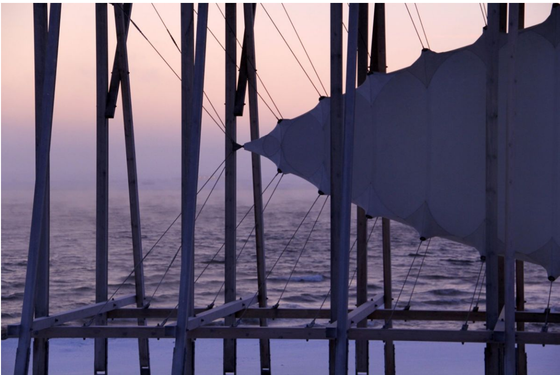
Fig. 6. Estructura y tejido tensado. Memorial Steilneset . Foto: Asbjørn Nilsen
