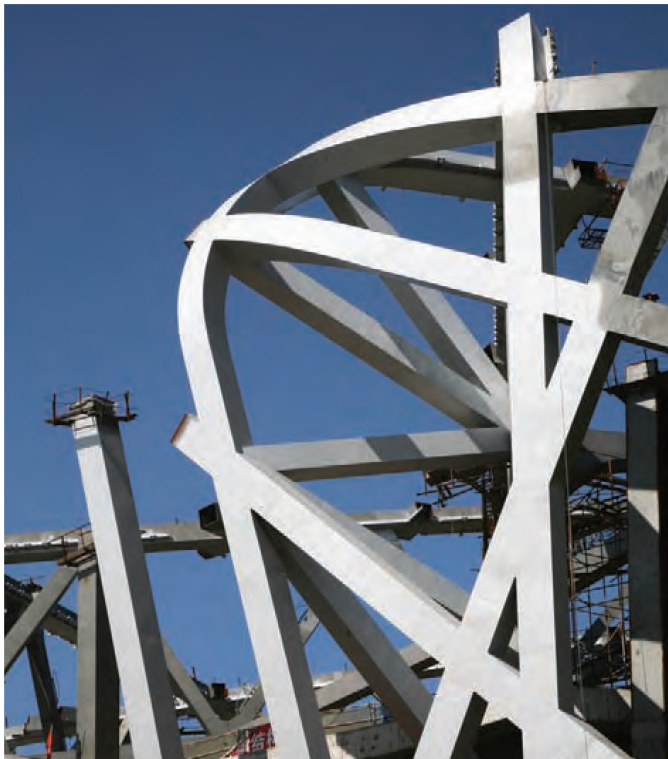
Fig. 16_ Elementos curvos en los aleros; detalle del mismo y elementos retorcidos, mostrando las cuatro superficies aplanadas. Fuente: Burrows, S. & Simpson, M. (2009). The Stadium geometry. The Beijing National Stadium Special Issue. The Arup Journal . 1.
