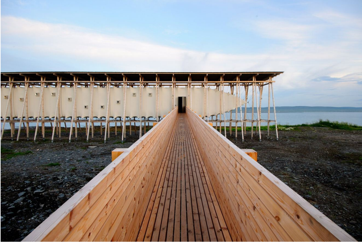
Fig. 11. Pasarela de acceso a Memorial
