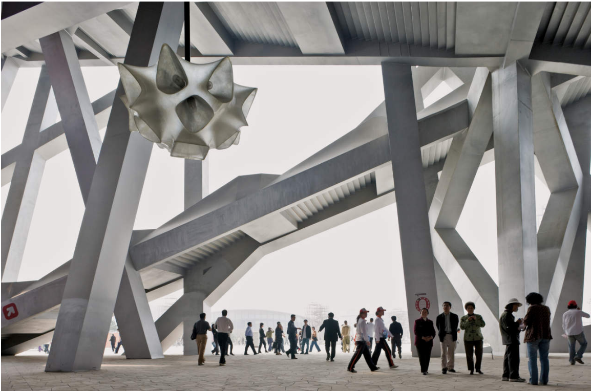
Fig. 4 _Las escaleras están entretejadas con la estructura de acero como elementos formales. Foto: Iwan Baan.
