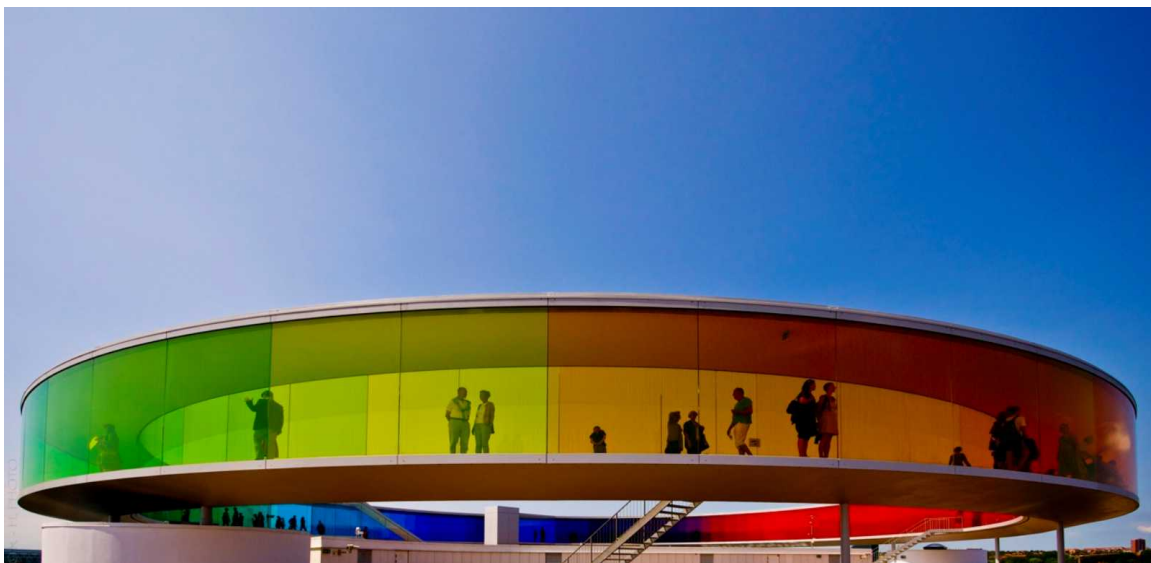
Fig. 11. La obra Your Rainbow Panorama está montada sobre columnas delgadas a 3.5 metros sobre la azotea del museo y tiene un diámetro de 52 metros, esta instalación artística permanente se extiende desde un borde a otro de las fachada del edificio del museo.
