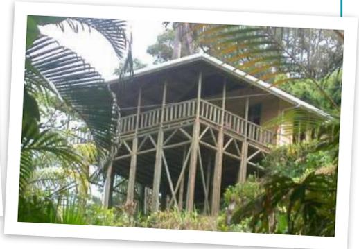
*La construcción de la casa levantada sobre el nivel del suelo protege de los animales y de las aguas en época de lluvias y facilita la circulación del aire*
