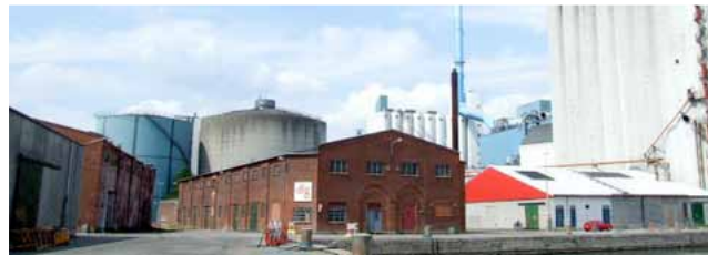
Vista panorámica del contexto industrial y la bodega de ladrillo
