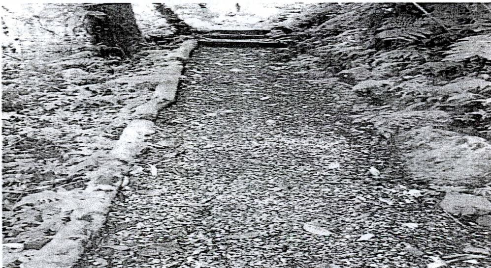
Estos senderos tienen la particularidad de contar con zanjas o canales en partes del recorrido, ubicados al ancho del mismo, permitiendo el drenaje de pequeñas quebradas para que lleguen al río sin lavar el material del sendero. Construidos por dos tablas de madera a ambos lados sostenidos por estacas de madera, con un ancho aproximadamente de 10 centímetros.
