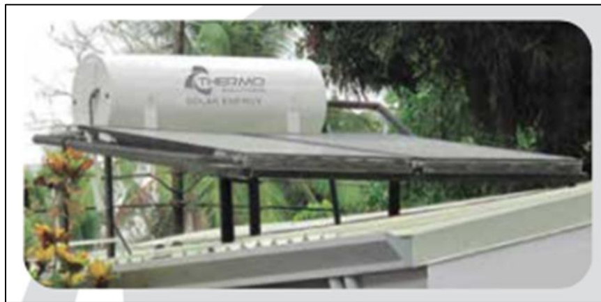
Figura 11. Solar Termosifón
