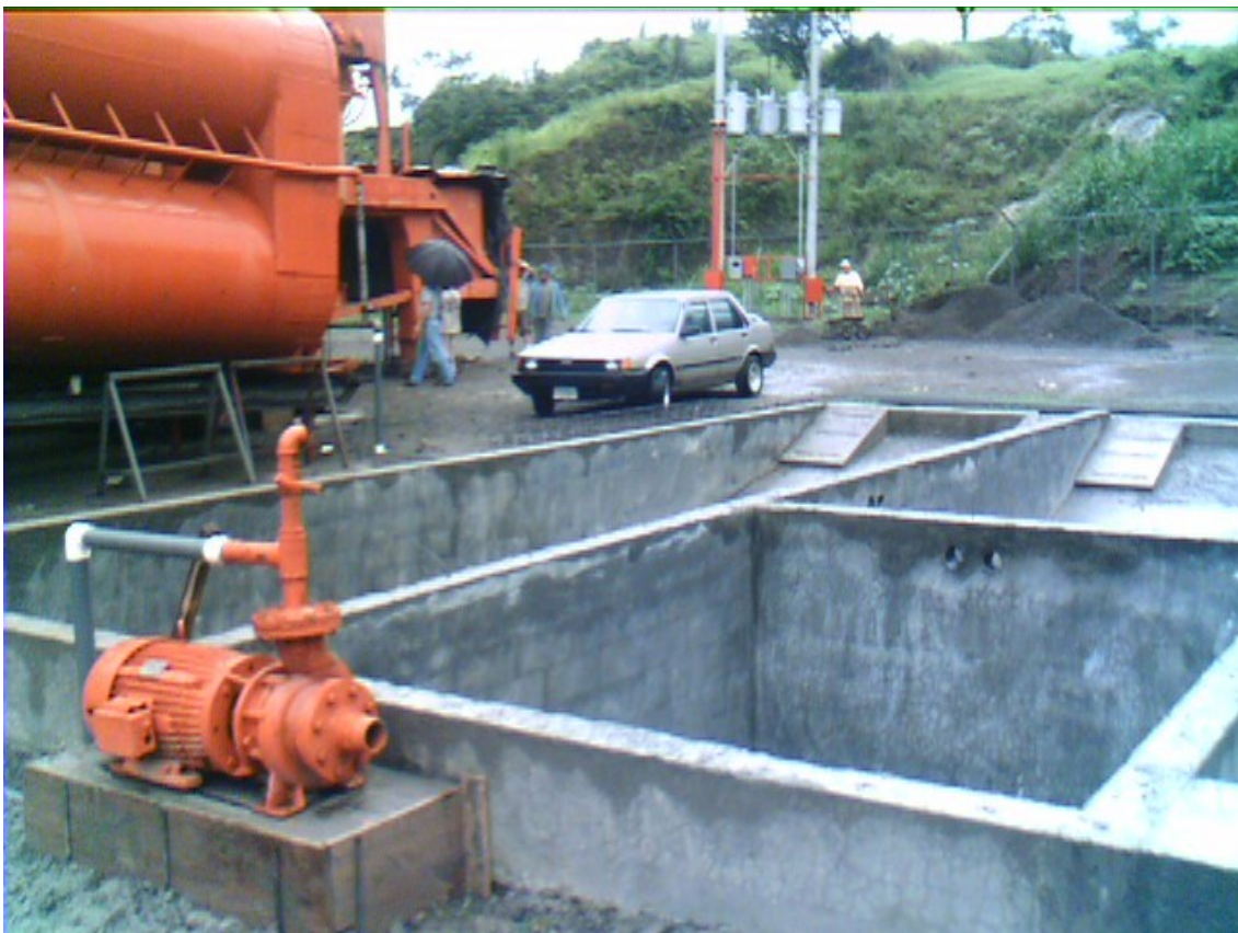
Fotografía 8. Piscinas de sedimentación.
