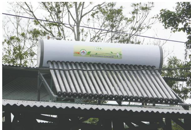
**Figura 14.** Descripción del tanque de calentamiento de agua por medio de la energía solar en el ML-SDA.
