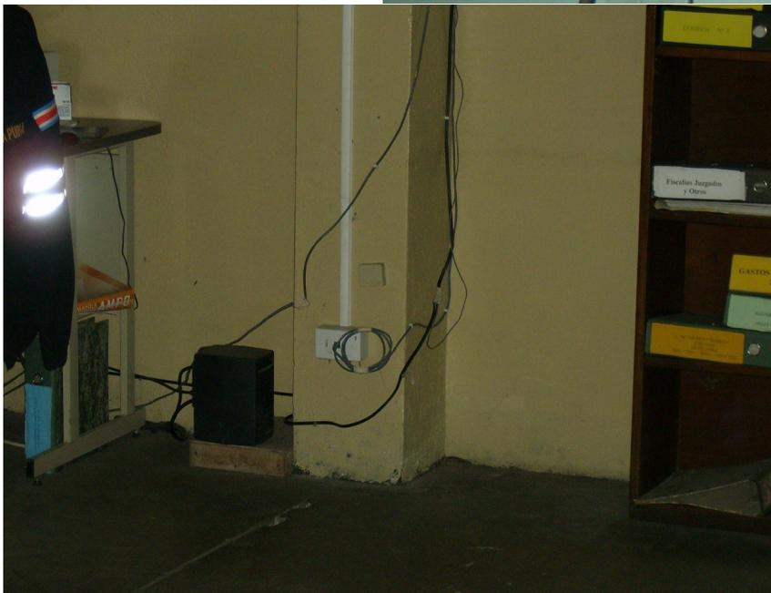
*Fotografía N° 15. Cables eléctricos expuestos que alimentan los tomas corrientes del equipo de cómputo y la UPS.*
