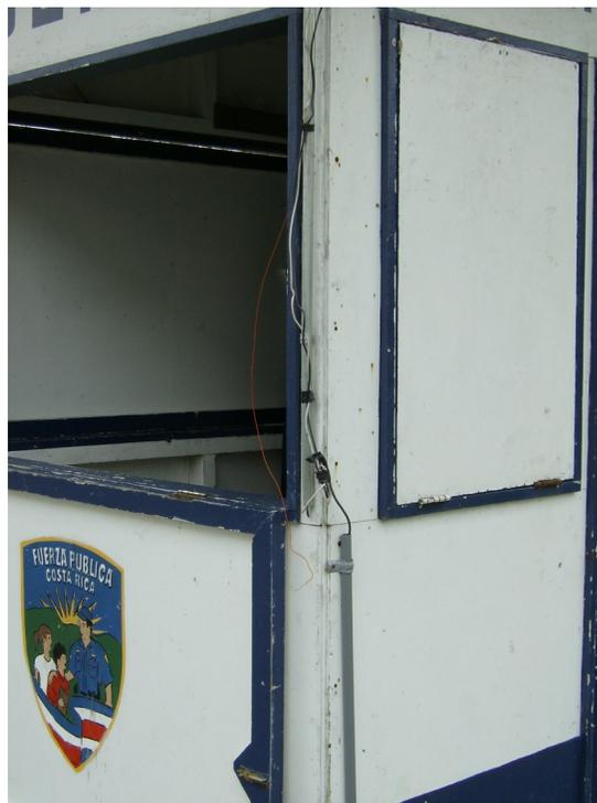
*Fotografía N°10. Caseta de seguridad con pegas entre los cables y expuestos al aire libre.*
