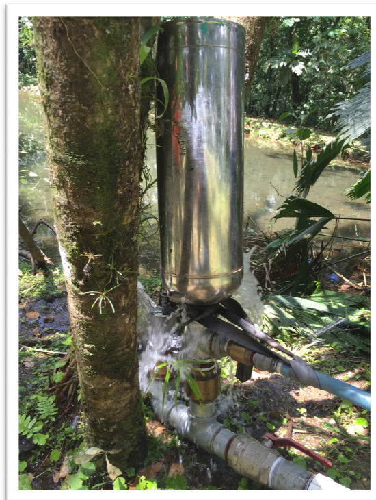
Figura 6. Ariete hidráulico en funcionamiento, prueba de campo.
