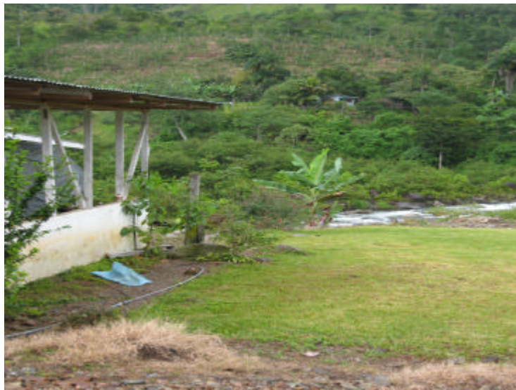
Fotografía 4.2-2. Casa ubicada en zona de inundación, sector de Pueblo Nuevo
