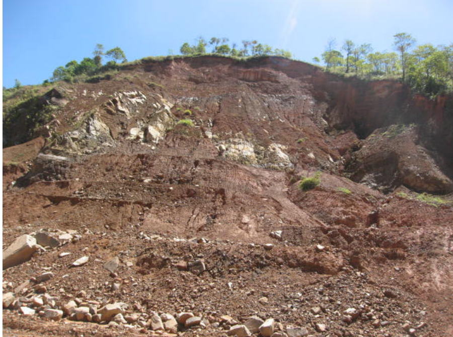
Fotografía 5.1- 6 Deslizamiento en San José de Rivas
