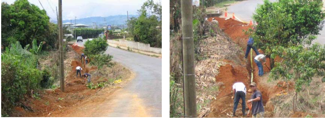
Fotografía 3.1-12. Zanjeado para tuberías provenientes de la fabrica Delji. Fuente: Marco Retana 2007.
