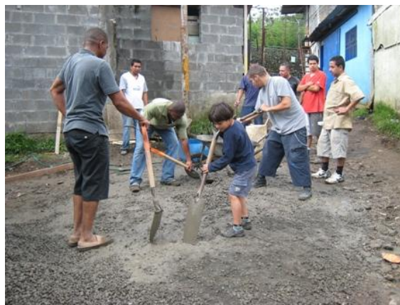
Construcción de acera. TC-568, Barrio Nuevo, 17/7/2011
