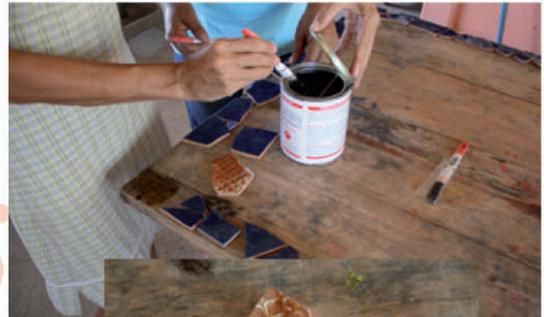
Una vez listos el material y la superficie, proceda a pegar los trozos: unte pegamento de contacto en ambas partes, dé un minuto de secado y una cada parte presionando contra la superficie. Trate de que el espacio entre las piezas de cerámica no sea mayor de medio centímetro para que la fragua luzca y se aprecie el diseño.
