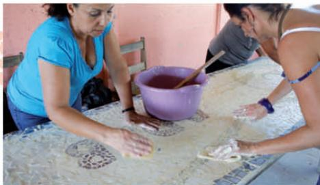
Prepare la fragua: vierta en una palangana la fragua en polvo y agregue agua hasta obtener una textura espesa como de atol, de esta manera, la mezcla penetrará con mayor facilidad en las pequeñas grietas.
